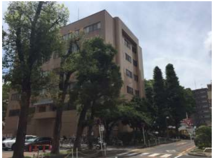
図1 岡山大学大学院保健学研究科の保健系学生が通う(通称)保健学科棟
