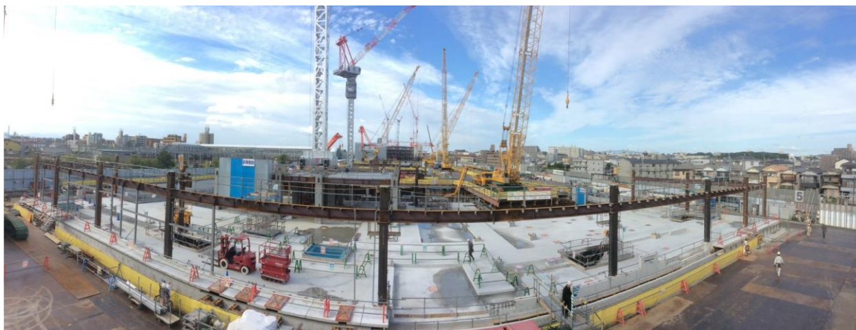
国立循環器病研究センター移転先の工事風景(東側から)
