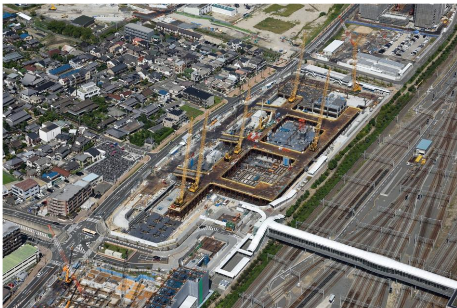
国立循環器病研究センター移転先の工事の全景 (右側は JR 東海道本線岸辺駅)
