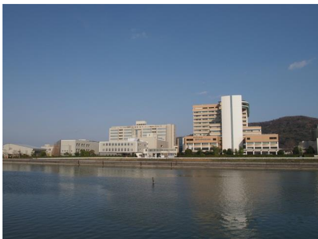
図 1. 大学の全景(西側の和歌川対岸から)
